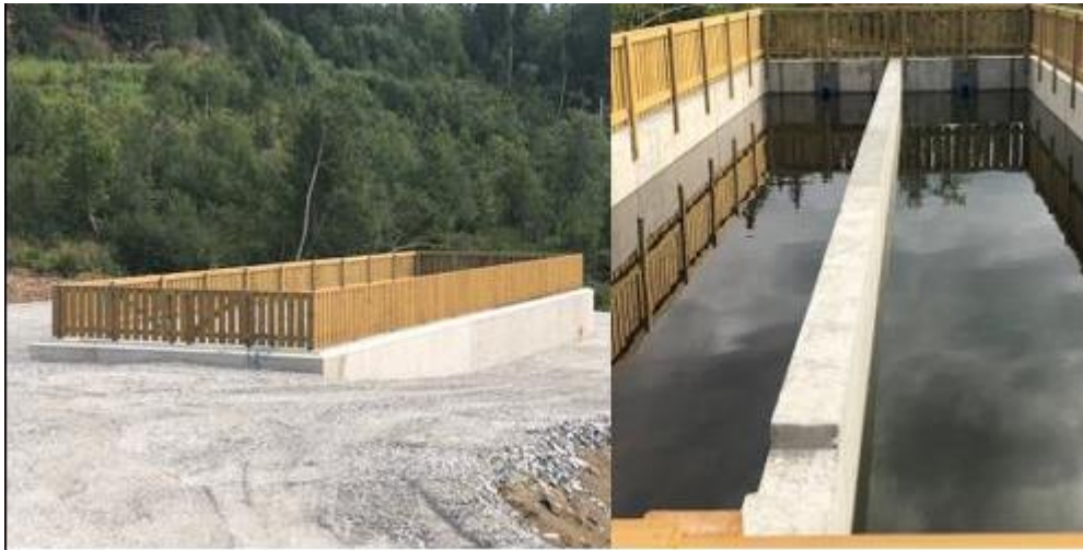
Figur 12: Bilde av sedimentasjonsbassenget (bildet er hentet fra årsrapport for 2018).
