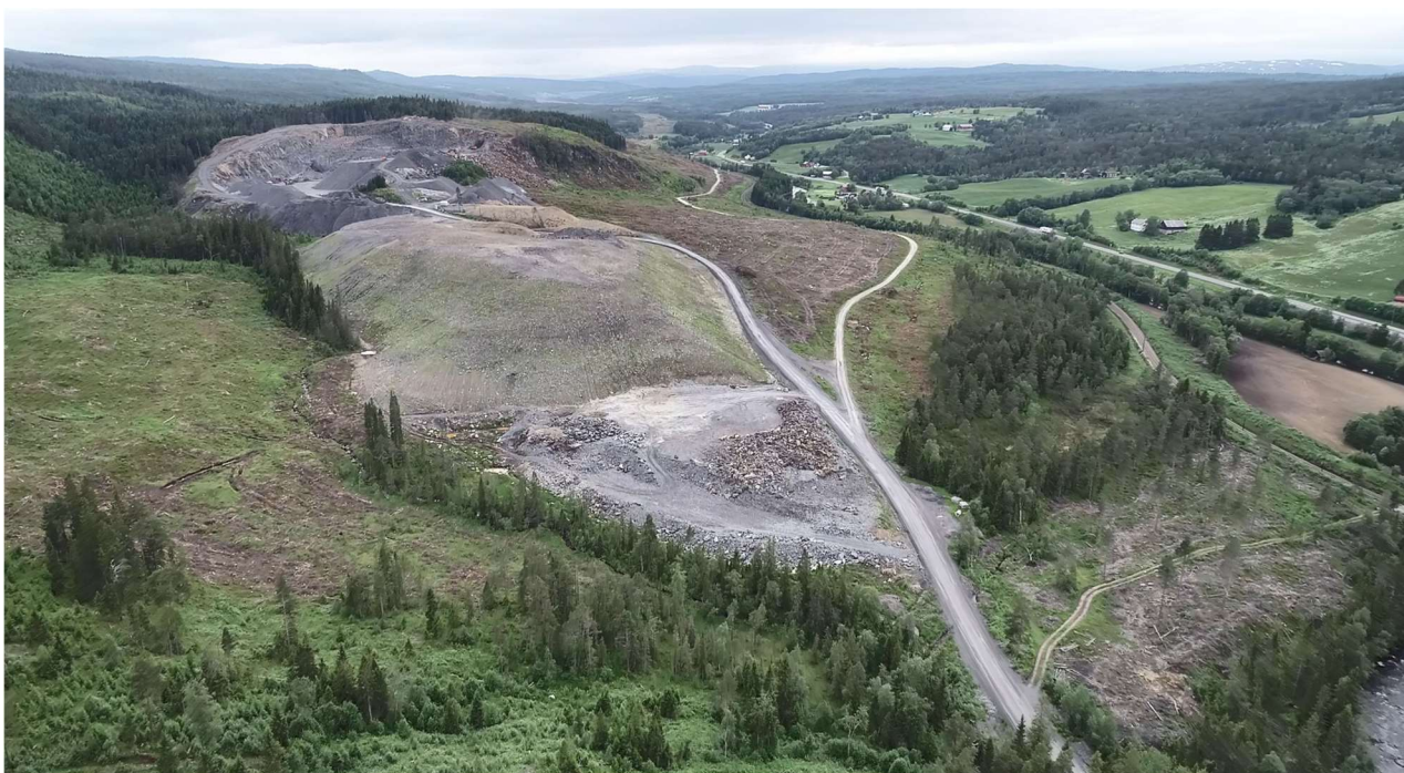
Figur 5: Dronebilde som viser adkomstvei opp mot deponi og pukkverket bakerst i bildet, eksisterende deponi (midt i bildet) og dalen som skal fylles opp (til venstre). (Kilde: FSR 2021)
